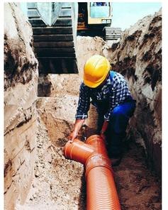
El PVC se utiliza mucho en las tuberías de alcantarillado por su bajo coste, su resistencia química y su facilidad de unión. Fuente: [https://commons.wikimedia.org/wiki/File:Laying\\_sewer\\_hi\\_res\\_\(2\).jpg](https://commons.wikimedia.org/wiki/File:Laying_sewer_hi_res_(2).jpg)
